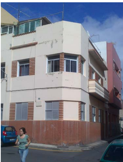
Lámina 20. Edificio racionalista (calle Santiago, 21)
